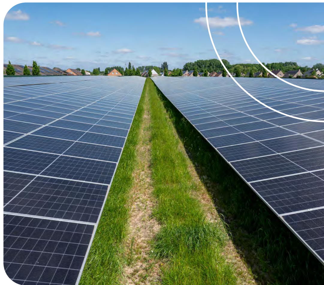
Eerste zonnepark, op grond van een woonmaatschappij in Lauwe. Bijna 8.000 zonnepanelen zullen 400 gezinnen voorzien van jaarlijkse groene stroom.
