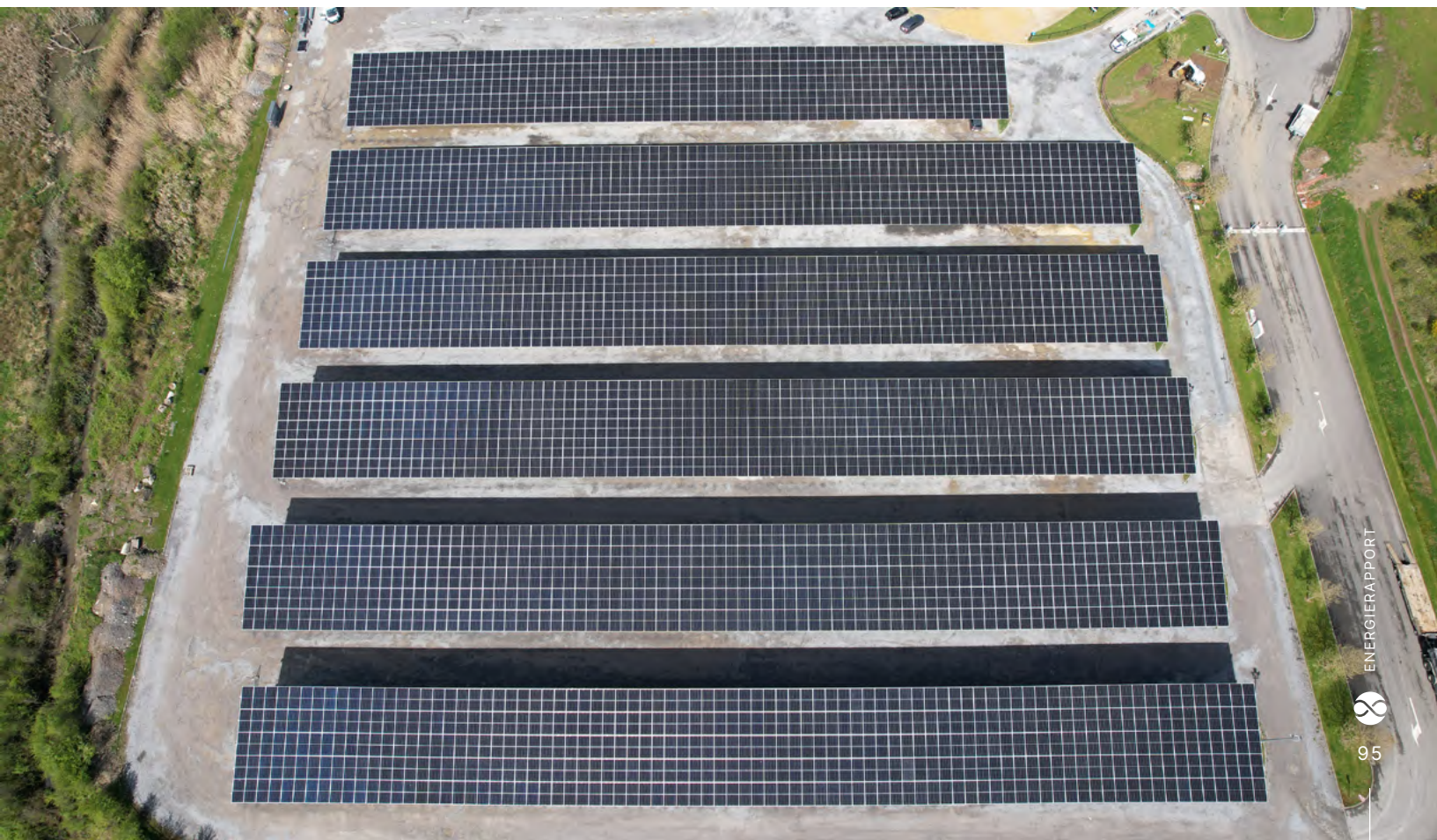
✓ De duurzame zonneparking in Adventure Valley in Durbuy met maar liefst 2.480 zonnepanelen.
